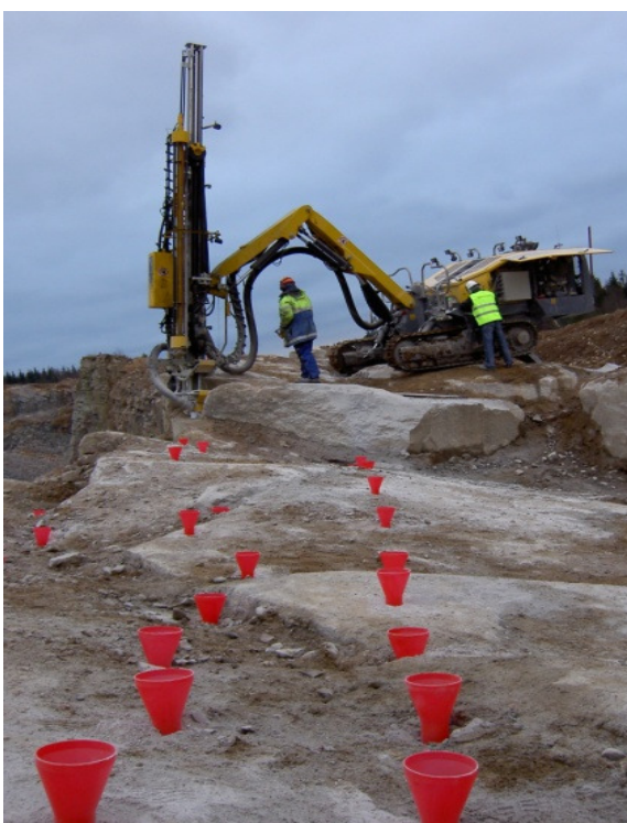
Figur 4.4 Borrning av laddhål.
