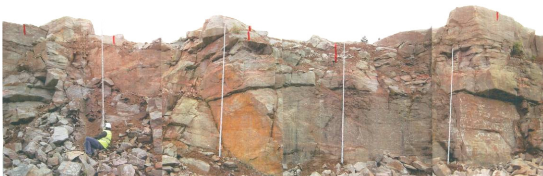
Figur 4.1 Inmätning av befintlig pallfront.
